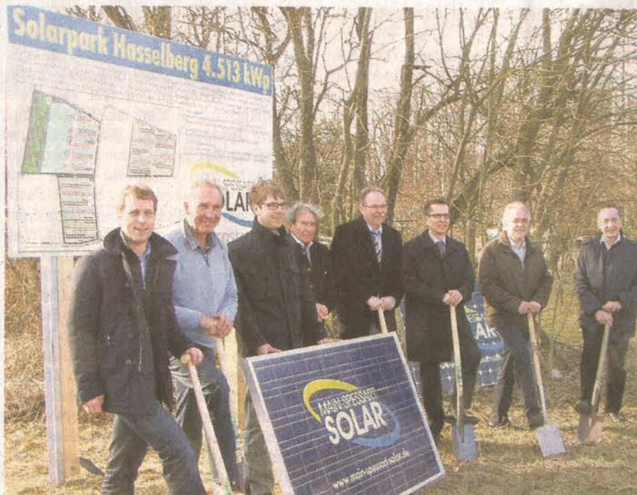
Spatenstich für die Solarpark in Hasselberg; von links: Bernd Büttner von der Main-Spessart-Solar GmbH; Rainer Ott und Tobias Büttner von der Solarpark Hasselberg GmbH & Co KG; Johann Eck vom Planungsbüro; Stefan Kopp und Jürgen Schäfer von der Sparkasse Aschaffenburg; Bürgermeister Karl-Heinz Schöffner und Leiter der VG Kreuzwertheim Gunter Krohnen. Foto: Rudi Fries
